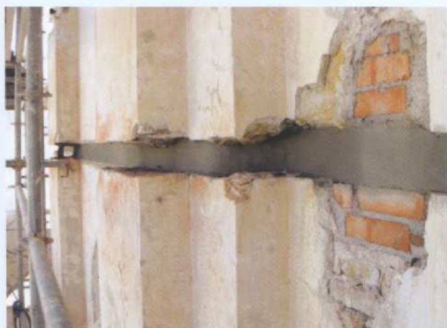
Figura 2 Preparazione del supporto delle fasciature
