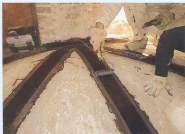
Figura 4/5 Applicazione nastri in fibra di carbonio all'estradosso della volta
