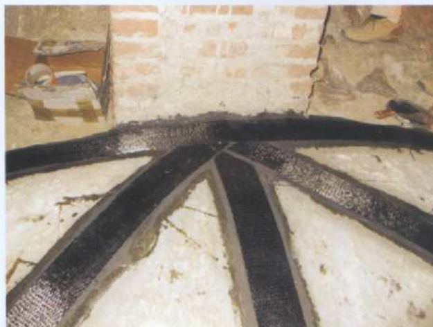
Figura 4/5 Applicazione nastri in fibra di carbonio all'estradosso della volta
